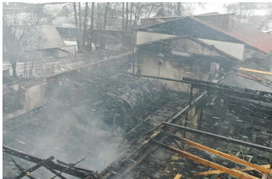
Brandwand zum Spänebunker stoppte die Ausbreitung.
