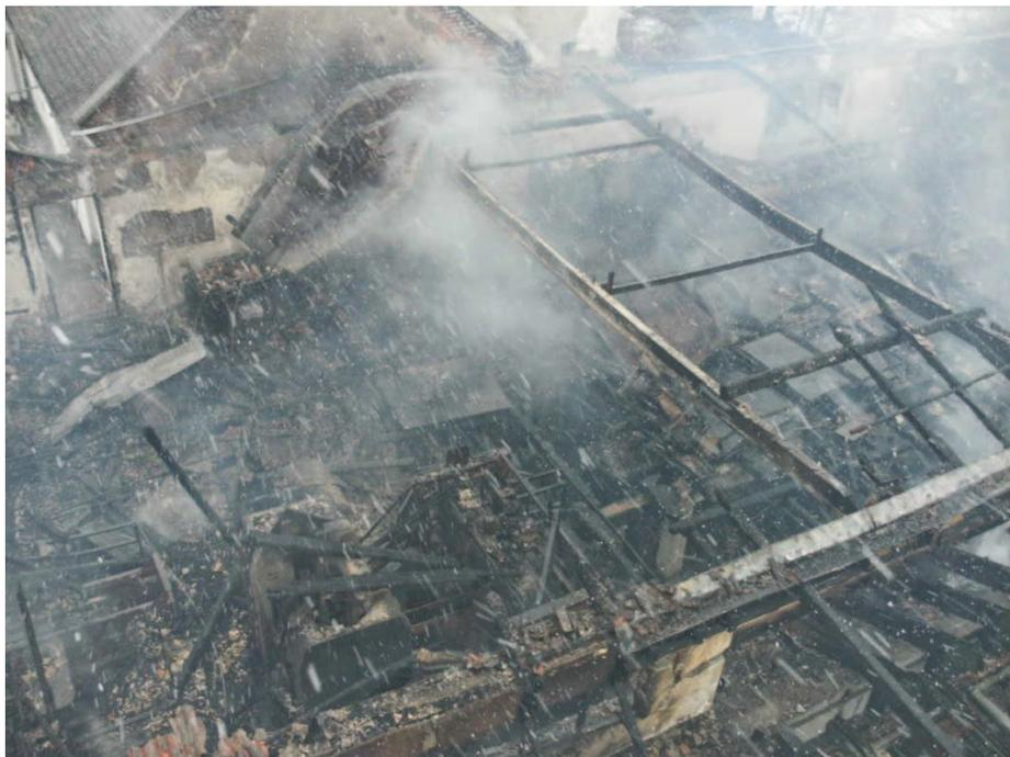
Brandwand zum Maschinenhaus konnte gehalten werden, durchgebogene Stahlträger führten zu Einsturzgefahr.
