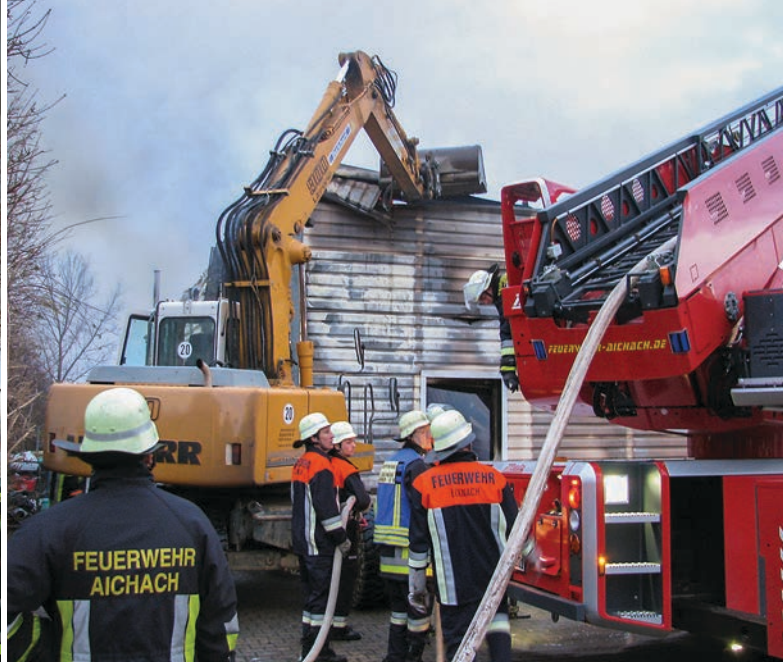
Mit zwei Baggern wurde die Blechfassade aufgebrochen.
