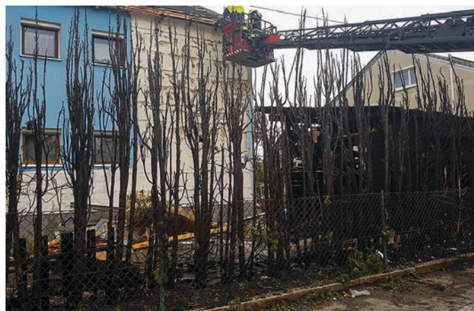
Der Brand griff auf die Wärmedämmung des Hauses über. Diese musste zum Teil entfernt werden, um Glutnester dahinter zu löschen. Bilder: Feuerwehr Kissing
